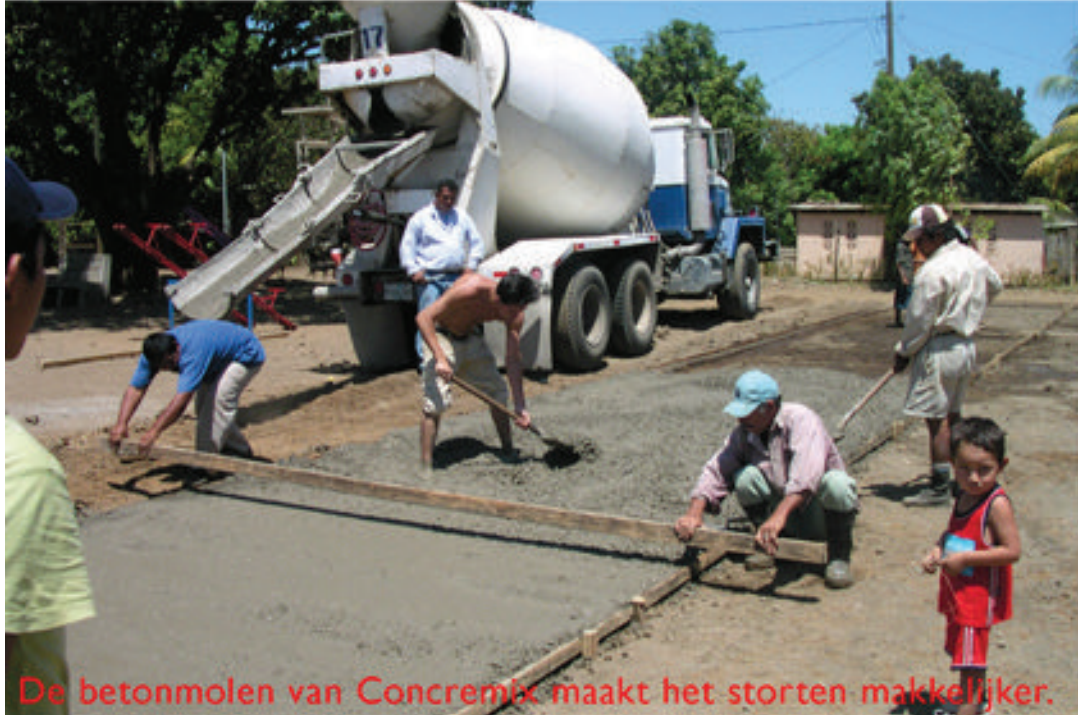
Uitscheppen en vèrdelen van het verse beton.
