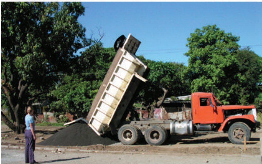
We kopen zand, grind en cement in om beton te kunnen maken. Het veld wordt in delen gestort, beton wordt handmatig gemixt.
