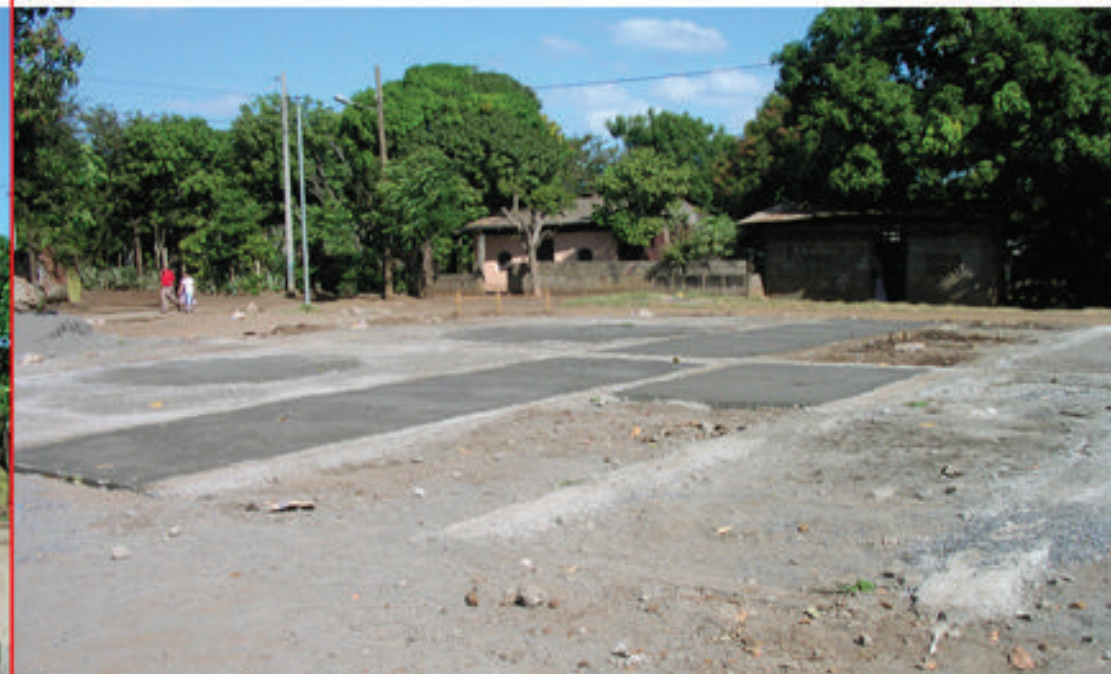
We kopen zand, grind en cement in om beton te kunnen maken. Het veld wordt in delen gestort, beton wordt handmatig gemixt.
